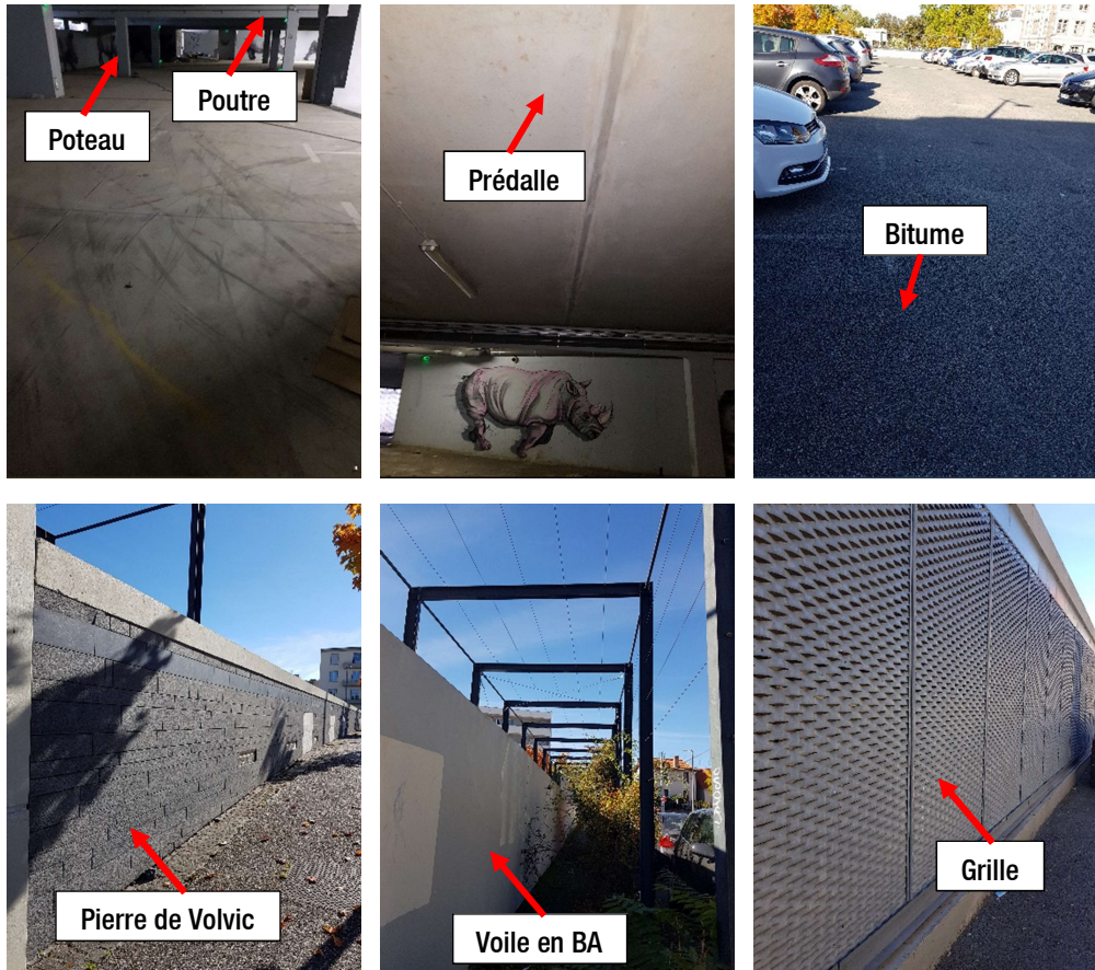
Illustration de la description du système constructif
